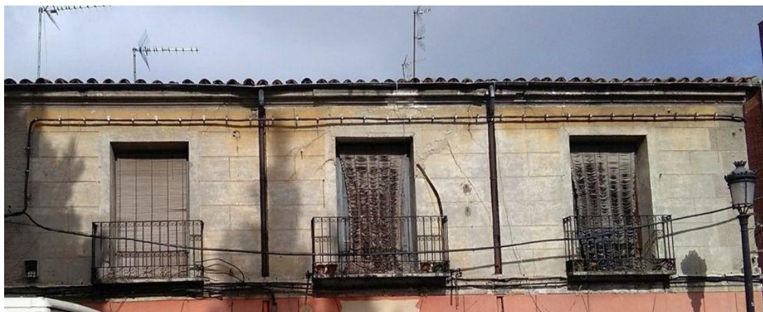
Balcones de la antigua casa en la Plaza París.
